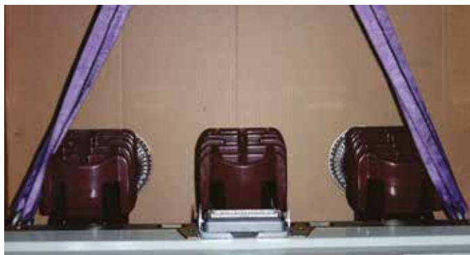
图. 4.1 3AE-SION EP®真空断路器的吊装（前视图）
