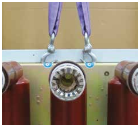
图. 3 3AE-SION EP®真空断路器的吊装
