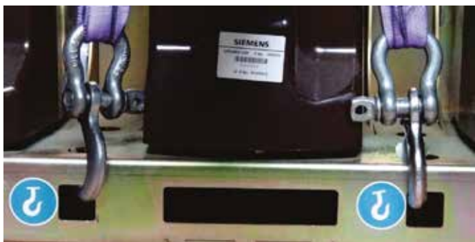
5.3 3AE-SION EP®真空断路器的吊装
